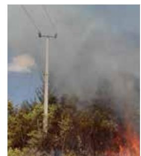
La altura de la vegetación aledaña **no debe exceder la altura del tendido eléctrico** para prevenir caídas accidentales sobre el cableado.
