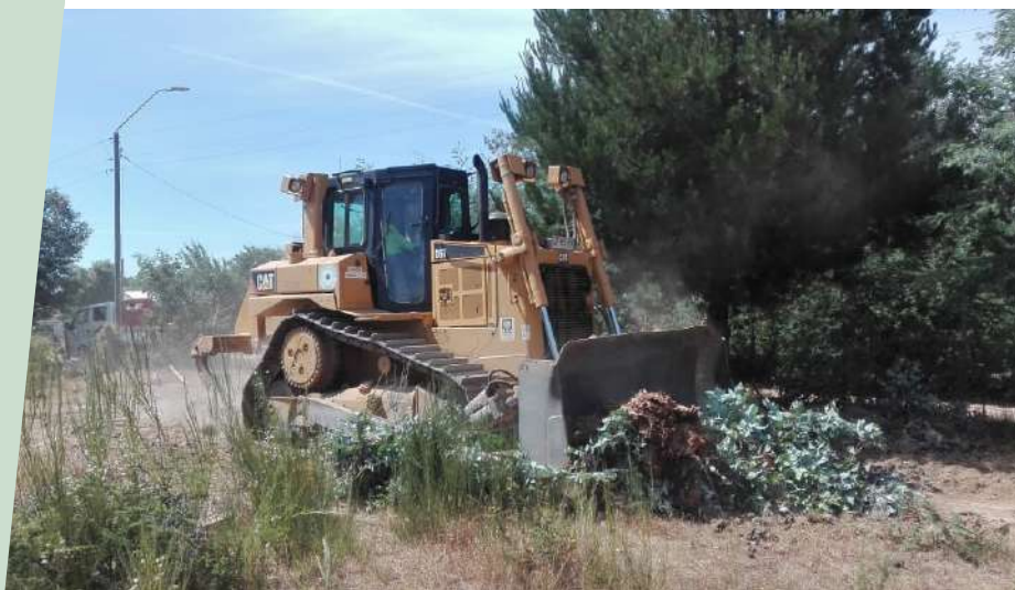
Figura 28: Uso de maquinaria.
